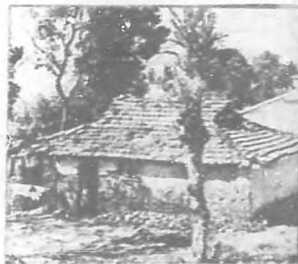
Con tierra fangosa y yerbas se construyen las paredes de estas viviendas. La estructura de madera s6lo es por la pared rudimentaria.
