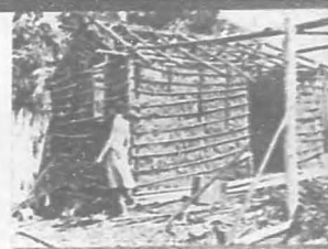
Casa de adobe en proceso de construcci6n.
