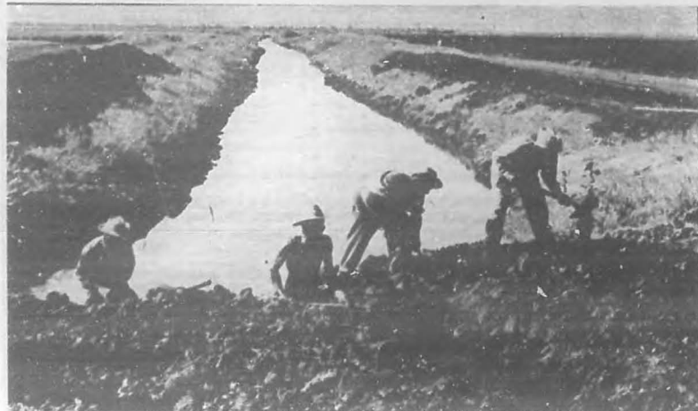
Construyendo canales para el sistema de regadío que se utilizará en las nuevas siembras de caña.
