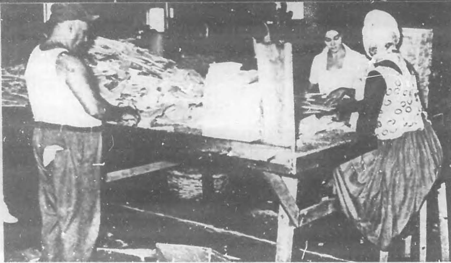
Requiere gran cuidado la selección de las tabillas, desechándose aquellas que no estén bien derechas o tengan nudos u otros defectos.
