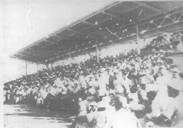
La construcción sólida ha sido una de las preocupaciones de la DGD en esta cruzada por hacer Campos Deportivos a lo largo y ancho de la Isla. Obsérvese el techo de esta gradería del Campo Deportivo de Mayarí, en la provincia d. Oriente.
