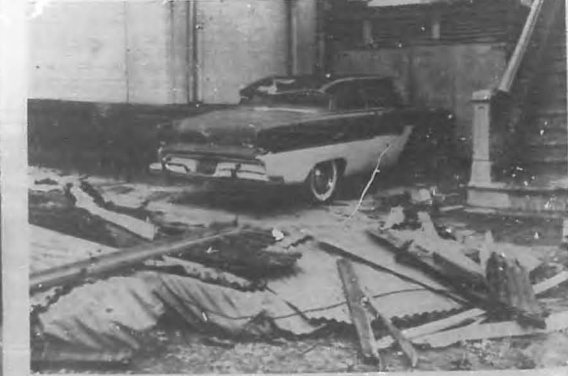
La peor destrucción en los edificios la sufrieron los techos debido a la velocidad furiosa del "Betsy". Este techo de una casa vecina fué arrancado de cuajo.
