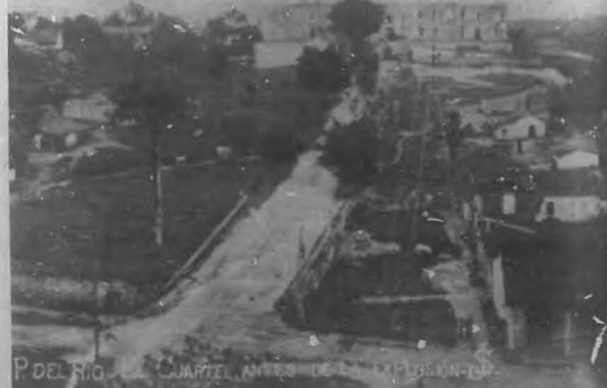
Así se veía el viejo cuartel central de Pinar del Río, situado en una prominencia del terreno en la capital vltabajera, poco antes de ocurrir la terrible explosión que lo redujo a polvo. Nuestro fotógrafo captó recientemente esta vista del lugar donde se hallaba el cuartel "Bavens", en Pinar del Río. Fue tomada desde el mismo punto que la antigua foto que reproducimos aquí también. Hoy sustituyen al edificio del cuartel varios centros escolares.
