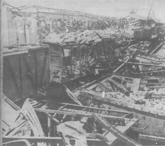
Estado en que quedaron los trenes y rieles en la Estación Ferroviaria de Cali, cerca de la cual estallaron los camiones cargados de dinamita. Los daños a la propiedad pasan de cincuenta millones de dólares.
