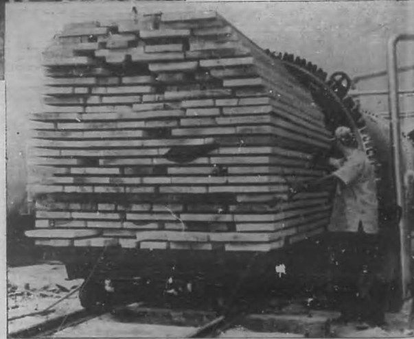
Los carros de madera blanda (en este caso almirón), entran en el largo túnel de hierro y acero para asegurarse 30 años de existencia. Maderas para muebles y construcciones, cogen un promedio de 10 galones de pentaclorofenol por 1,000 pies de madera. Para postes y traviesas, la madera entra en bolo.
