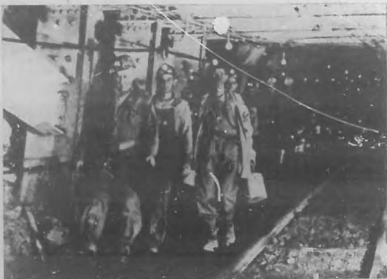
Mineros americanos se dirigen a su trabajo. Nótese el equipo del personal: casco de protección; ropa especialmente confeccionada para evitar la acción de los tóxicos sobre la piel; guantes, zapatos especiales, etc. La galería, está perfectamente reforzada con vigas poderosas que prevén todo posible accidente.
