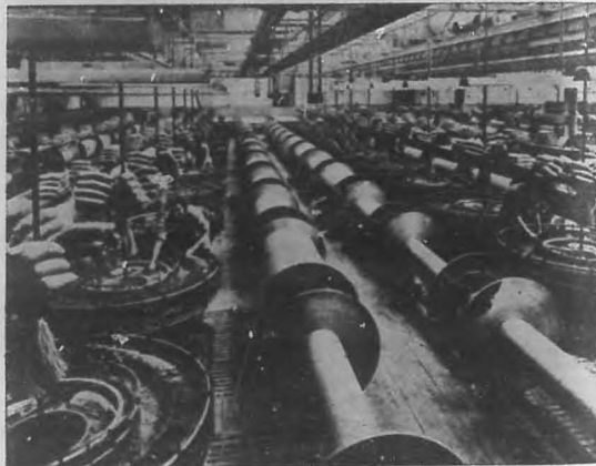
Instalación de telares circulares en una gran industria manufacturera de sacos de azúcar en Francia.
