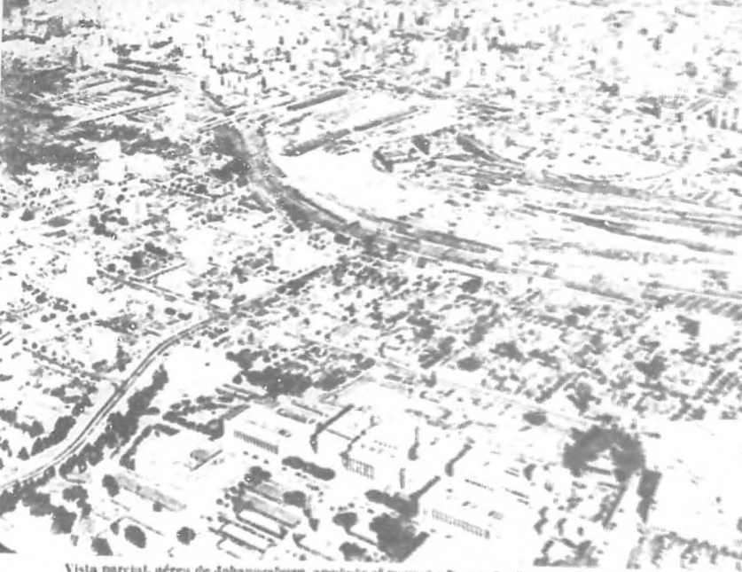
Vista parcial, aérea de Johannesburg, apostada el pequeño Nueva York por su abundancia de cruceños.
