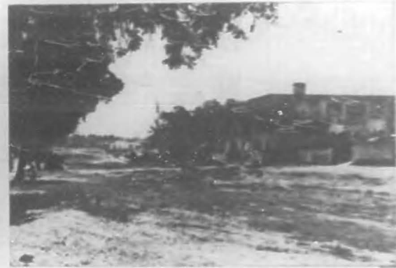
Esta es la Avenida Menocal, del Reparto "La Lira", con otro camión apreado por el lodé.
