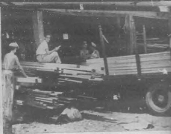
13—Camiones repletos de madera elaborada para llevarla a una industria derivada o a una obra en construcción. Ya el material está en condiciones de ser utilizado.
