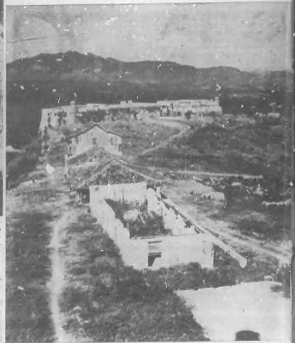
Edificaciones exteriores al castillo. Alrededor frente a la costa sur y delante del costado izquierdo del castillo, se conserva la planta de una serie de edificaciones auxiliares de la fortaleza: pabellón de artillería, capilla, casa del capellán, etc. Sobre las viejas bases se han realizado nuevas construcciones, a veces utilizando parte del material antiguo en las puertas, paredes y techumbres. A la derecha, casi en el primer término, quedan huellas de la casa del gobernador de la fortaleza. En el fondo, la fachada principal del Morro.
