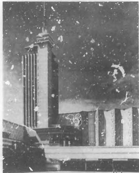
La bella torre del Palacio de la Ciencia
