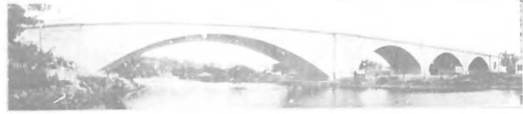
Puente "Almendares" construido con el cemento producido en la fábrica.
