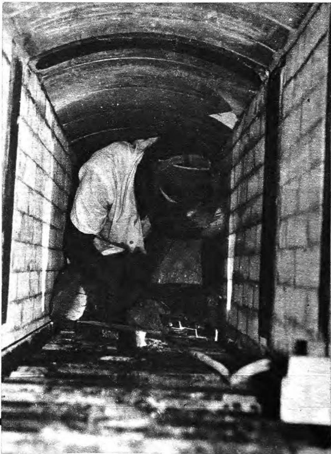
Modernos hornos túneles del tipo muflado que queman el producto por radiación están siendo instalados en la nueva inversión de la planta de cerámica blanca "Adalberto Vidal".
