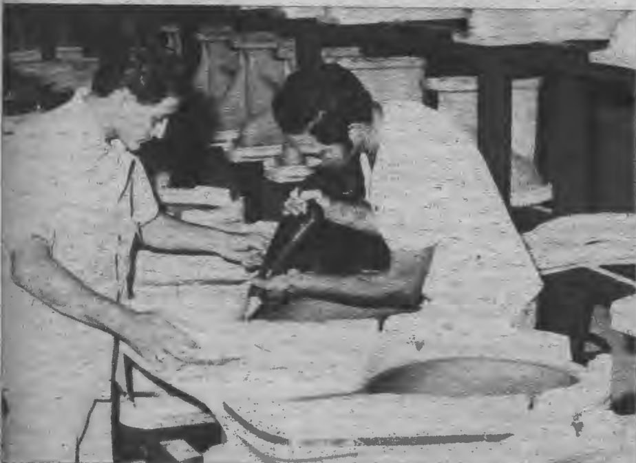
Planta de Muebles Sanitarios instalada en la provincia de Holguín.
