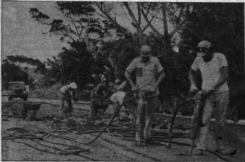
La Brigada de la región Camilo Cienfuegos, trabajando en la reparación de la Carretera Central.
