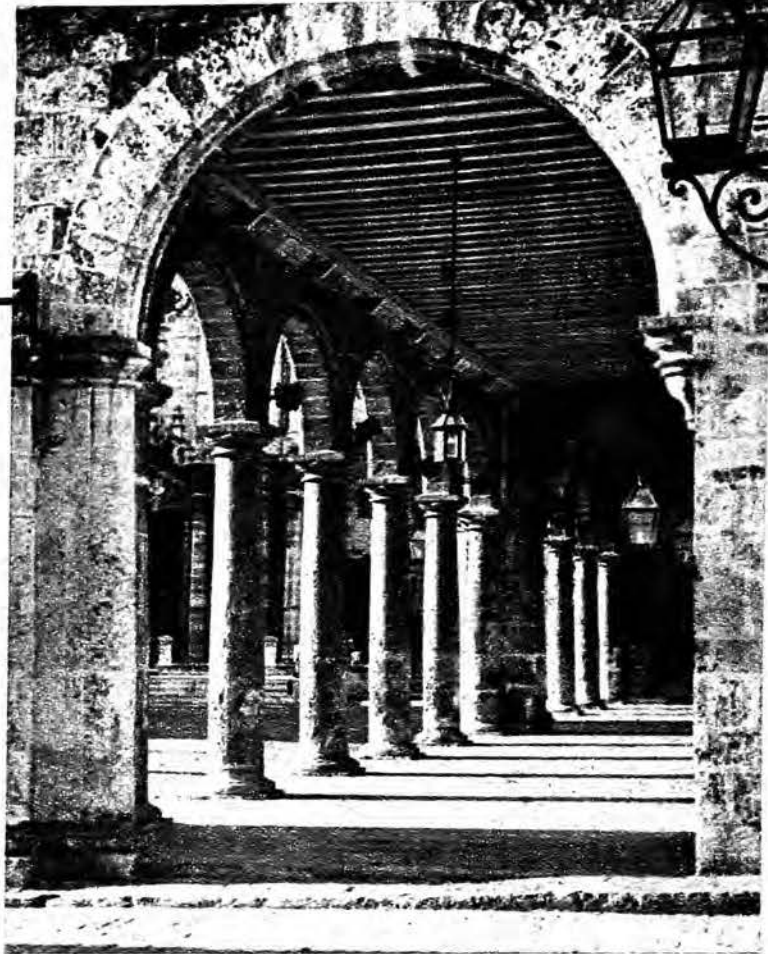
El techo del portal de la que fuera casa de Lombillo, al igual que sus faroles, fueron restaurados.
