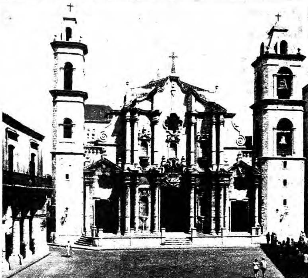
En la fachada de la catedral se lleva a cabo actualmente un amplio plan de restauración. La luceta de cristales cuadrículados, del óculo central, será restituida a su diseño de finales del siglo XIX, mediante estos trabajos.
