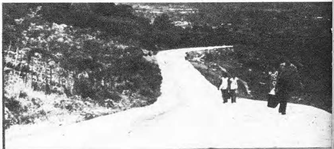
Un tramo de la carretera que enlaza a "Los Negros" con "Matías".
