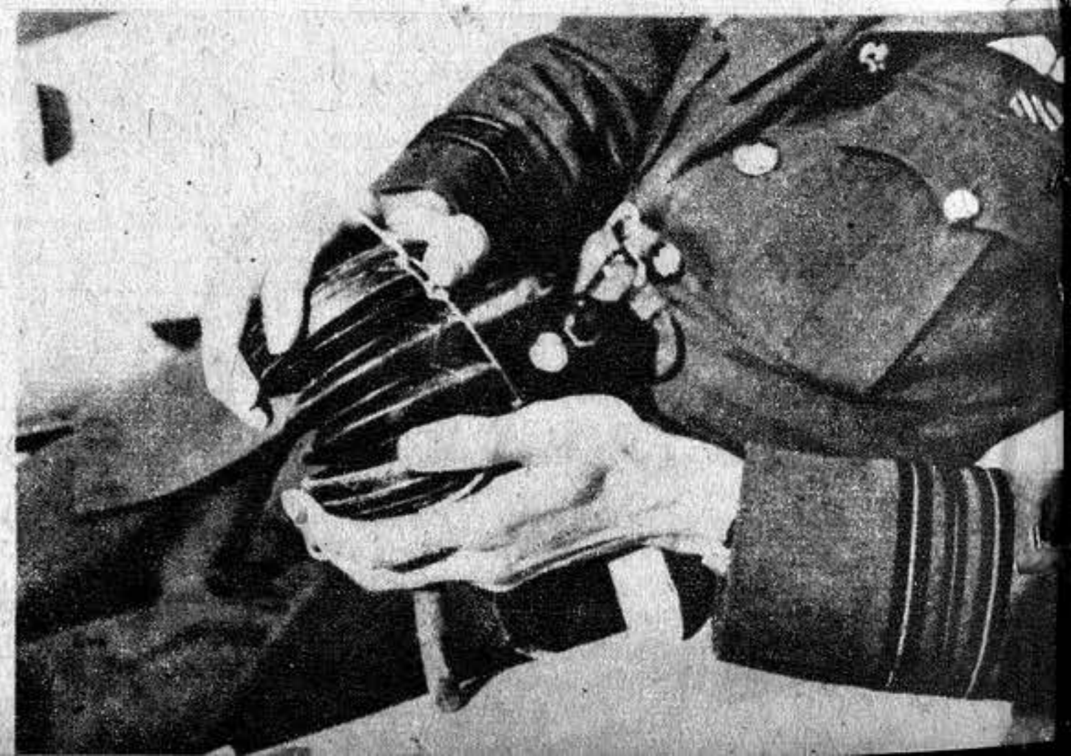
La bomba de emergencia está construída con un sistema de fuelles. Ella ha de permitir al piloto reinflar su bote de goma si fuera necesario. Por su forma ocupa un espacio muy reducido.
