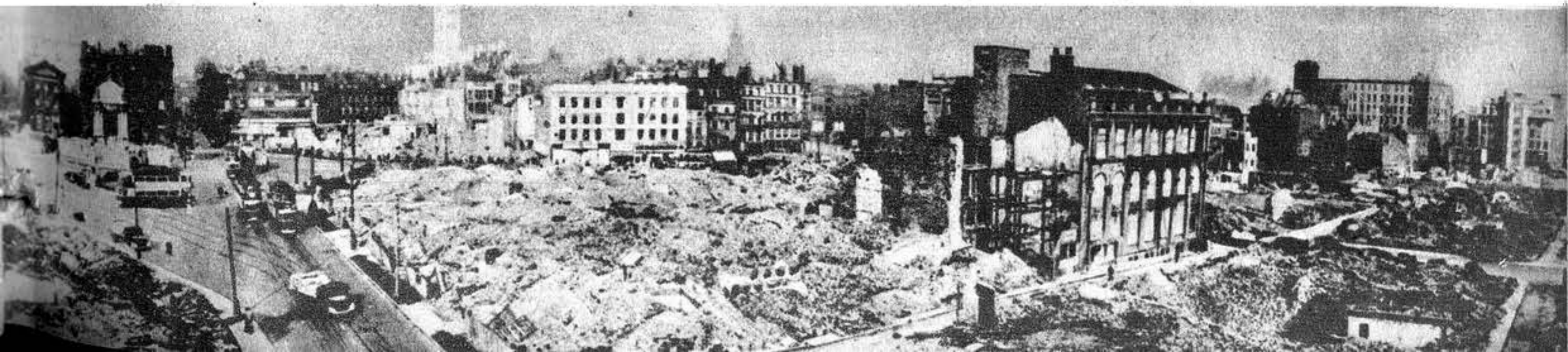
Otra ciudad en escombros: Una vista del "Victoria Memorial" y Lord Street de Liverpool, salvajemente bombardeada en varias ocasiones por la aviación nazi durante el invierno de 1940.
