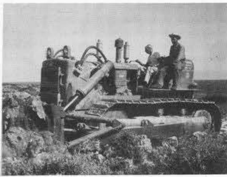
Al sur de la Península de Guanahacabibes, por encima del arrecife, las bulldozers del INRA construyen una carretera que irá de Cortés al Cabo San Antonio.
