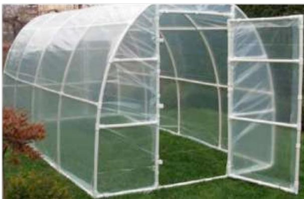
**Figura 8.10** Invernadero casero de pvc y cubierta de plástico.
