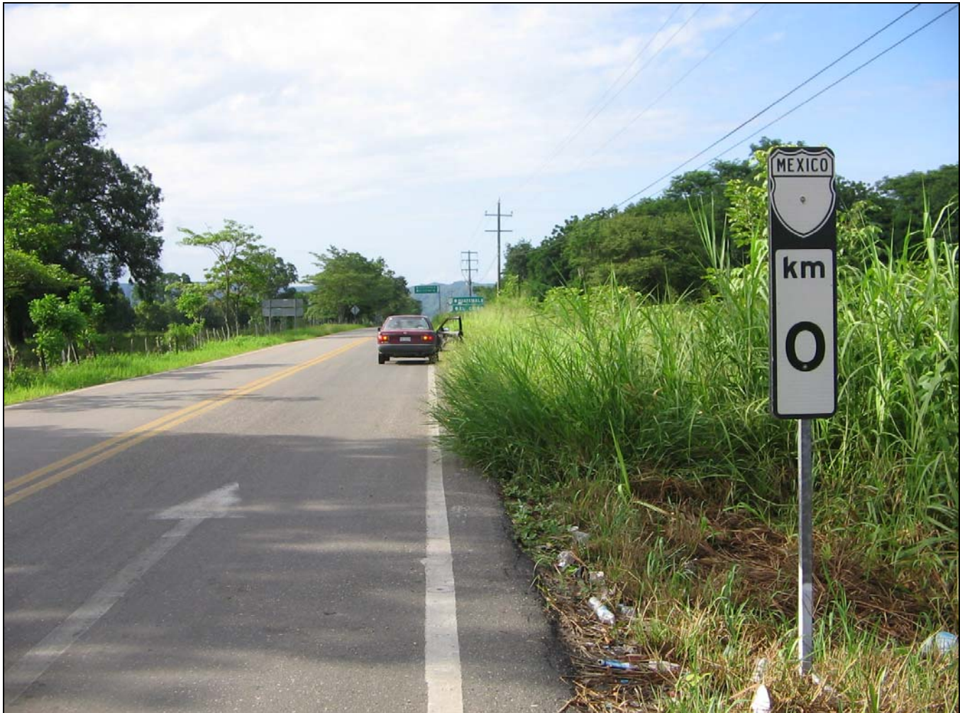
Fotografía 1. Donde se logra observar que el poste de kilometraje marca cero (de la carretera Tenosique-El Ceibo ), lo que correspondería al km 75+000 de la carretera Entr. Emiliano Zapata-Tenosique-El Ceibo .
