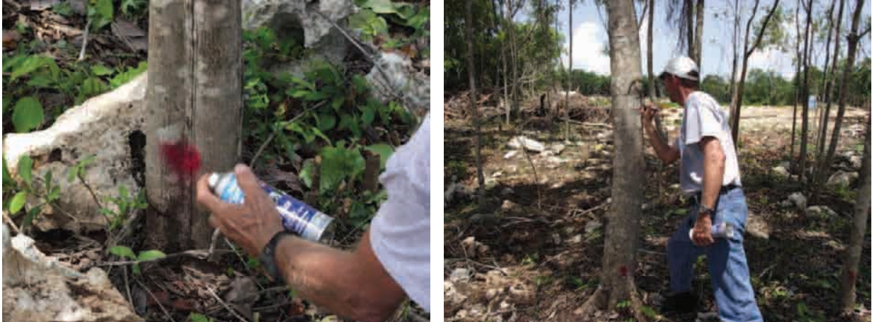
Figura 15. Proceso de marcado de los elementos que no interfieren con el desplante para su conservación.
