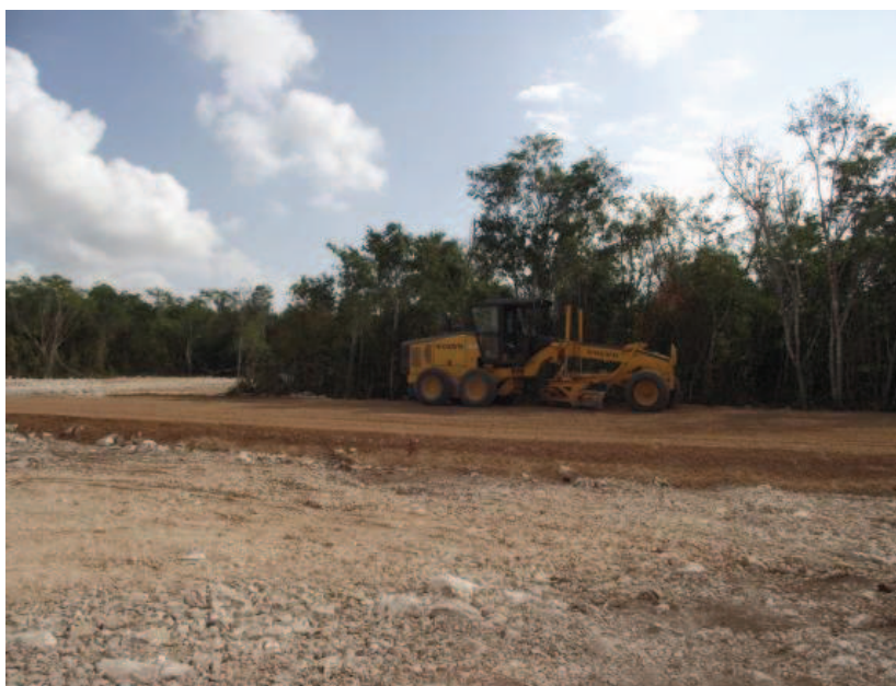
Figura 22. Labores de nivelación y compactación del terreno.
