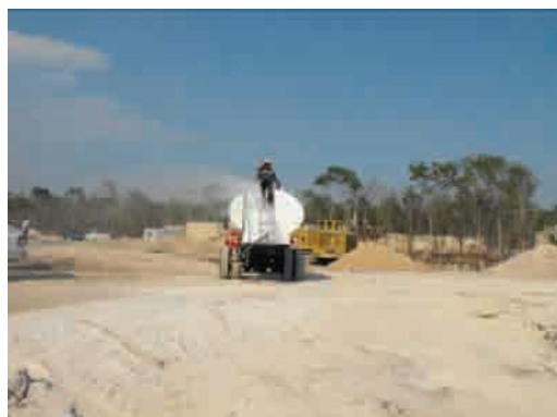
Figura 13. Aspersión de agua en pipas para el control de polvo.
