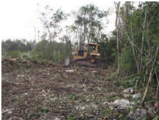
Figura 21. Obras de desmonte y despilme dentro del predio en las zonas que ya fueron desmontadas.
