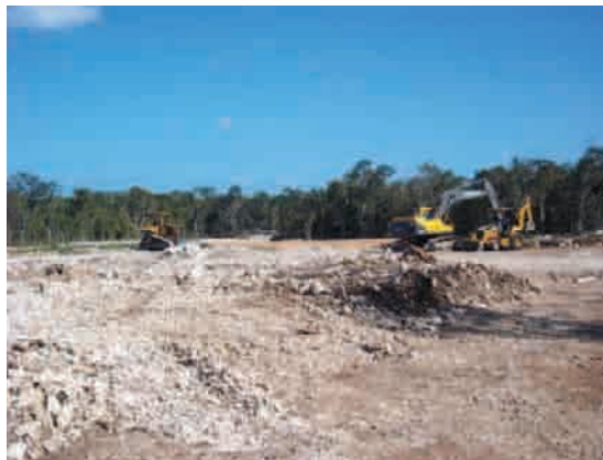
Figura 21. Obras de desmonte y despilme dentro del predio en las zonas que ya fueron desmontadas.
