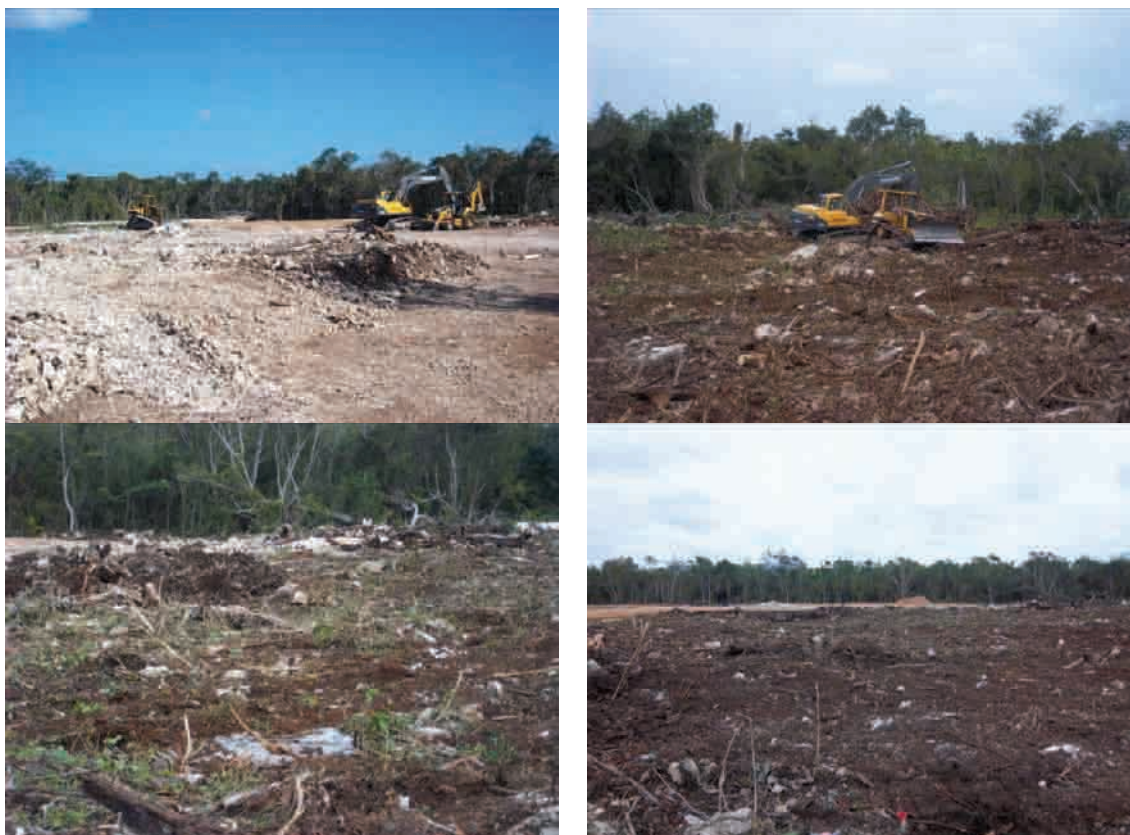
Figura 11. Imágenes de la zonas que han sido desmontadas.
