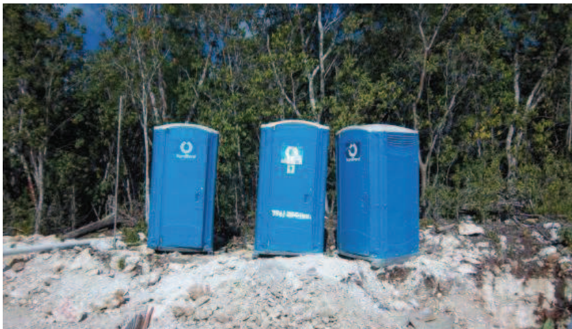
Figura 27. Algunos de los baños portátiles que se encuentran en el pedio para uso de los trabajadores.
