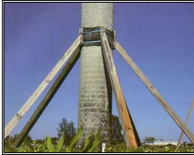
Figura VI.9 Tutor tipo tensores de madera en una palma con más de 6 m de altura.
