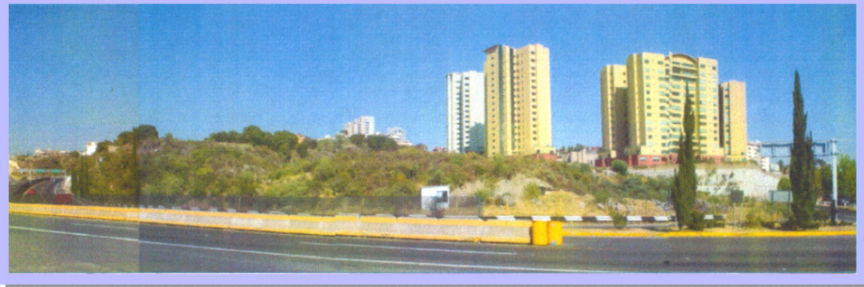
Vista Sur–Norte del sitio del proyecto. En segundo plano el conjunto Condominios Placet.
