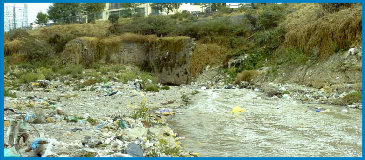
VISTA NORTE- SUR DEL TRAMO DEL RÍO SAN JOAQUÍN (PROYECTO DE ALCANTARILLADO Y ENTUBAMIENTO)
