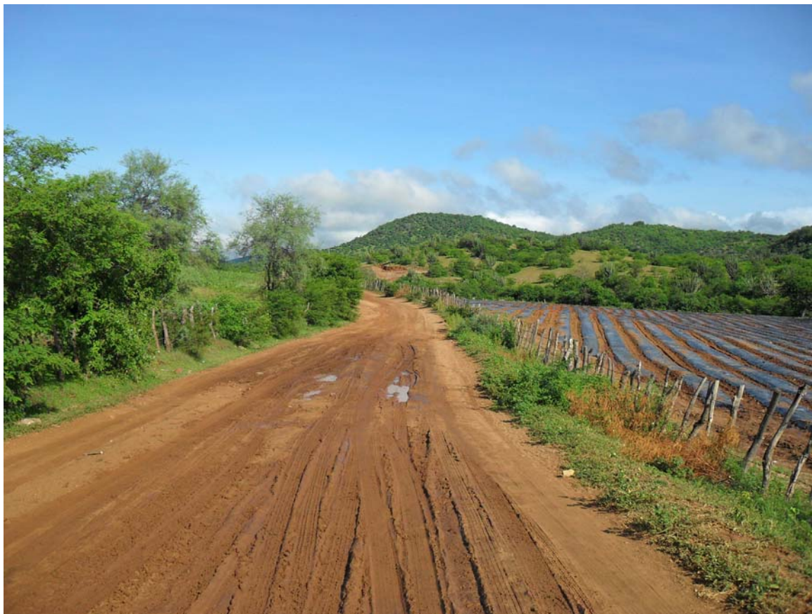
Fig. III. 9. Vista del Camino.
