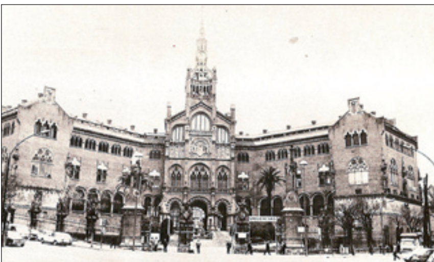
Figura 2. Hospital de la Santa Cruz y de San Pablo, de Barcelona.
