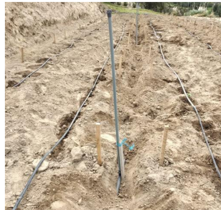
Anexo 30: Colocación de hidrantes
