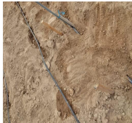
Anexo 31: Finalización de instalación
