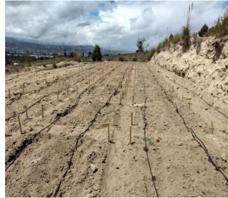
Anexo 29: Instalación de sistema de riego
