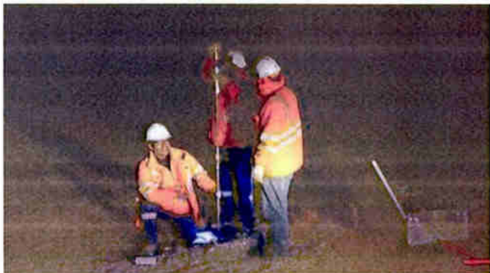
FOTOGRAFÍA 3-9. Prueba DCP del Material de la Capa de Asiento Debajo de la Estructura Existente de la Calzada.
