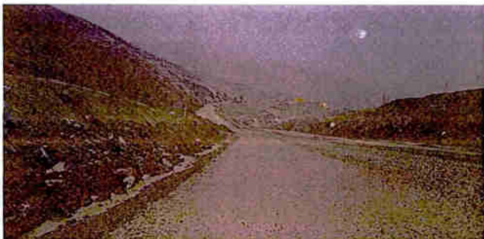
FOTOGRAFÍA A10-3. Control de calidad en el Tramo I – Funcionamiento de cunetas.
