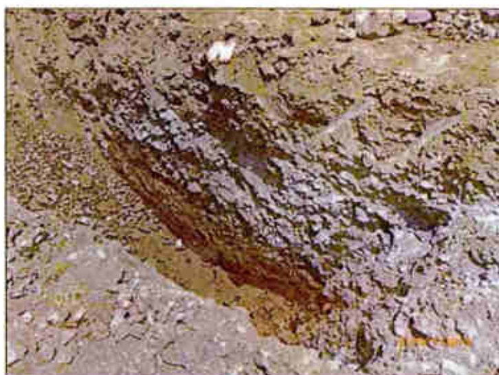
FOTOGRAFÍA 3-3. Pozo de Prueba que Muestra la Excavación a Través de toda la Calzada hasta el Nivel de la Capa de Asiento Natural.
