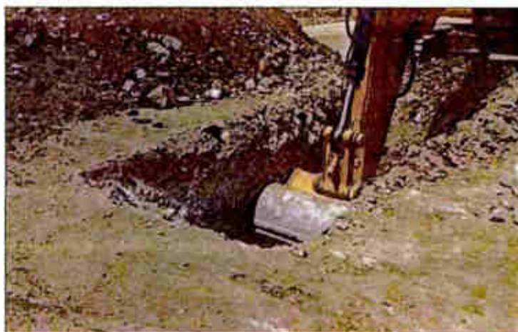
FOTOGRAFÍA 3-2. Excavación de un Pozo de Prueba en la Calzada de una Vía de Acarreo Existente.
