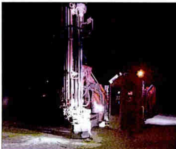
FOTOGRAFÍA 3-6. Orificio de Acceso Perforado Previamente con Taladro para Roca a Través de la Calzada Existente.
