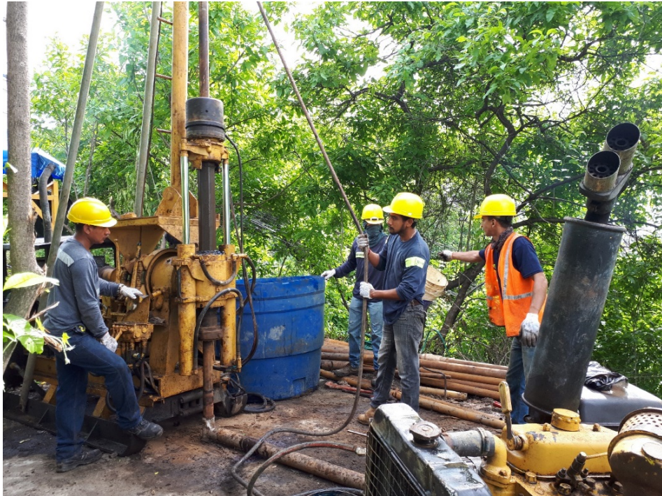
Figura 11. Equipo empleado para los sondeos SPT.
