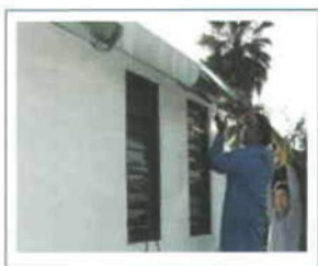
Figuras 7 y 8. Colocación de canaletas.
