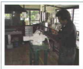
Figura 1. Corte de solera.
