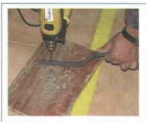
Figura 3. Perforación de solera.
