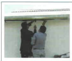
Figuras 7 y 8. Colocación de canaletas.
