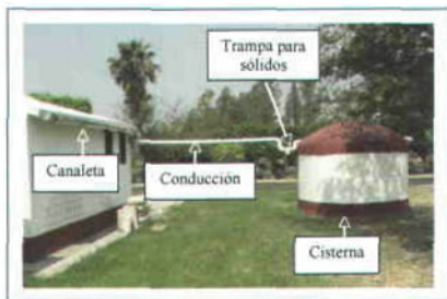
Figura 15. Sistema de conducción de agua de lluvia.
