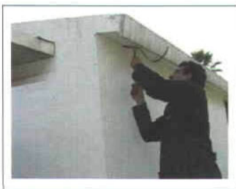
Figura 5. Colocación de ménsulas.
