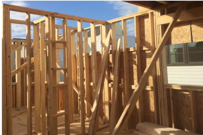
*Enmarcado de paredes exteriores e interiores*
