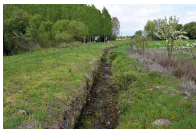
Tramo de calzada romana desbrozada. Se observa el zanjón de drenaje o cuneta que practicaban los romanos.
