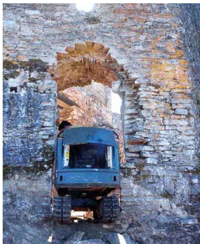
Oruga entrando a desescombrar en el baluarte.
