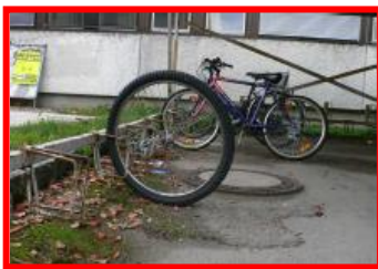
Les supports de type "étriers de roue avant" ou "supports de guidon" n'offrent pas de protection suffisante contre le vol ou les dommages photo: verkehrspuls
