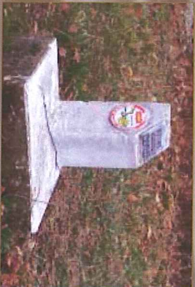
Borne de signalisation du Pipeline Sud Européen
