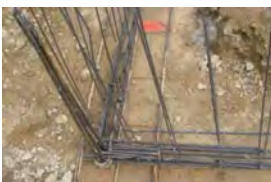
Noeud de chaînage - Continuité mécanique
