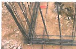
Noeud de chaînage - Continuité mécanique
