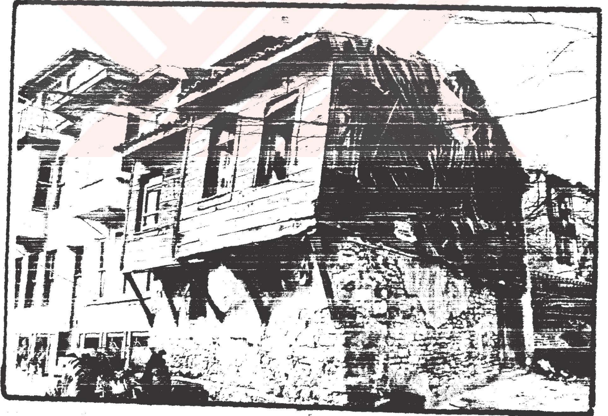
Kariye evleri Restorasyon Öncesi Görünüş
