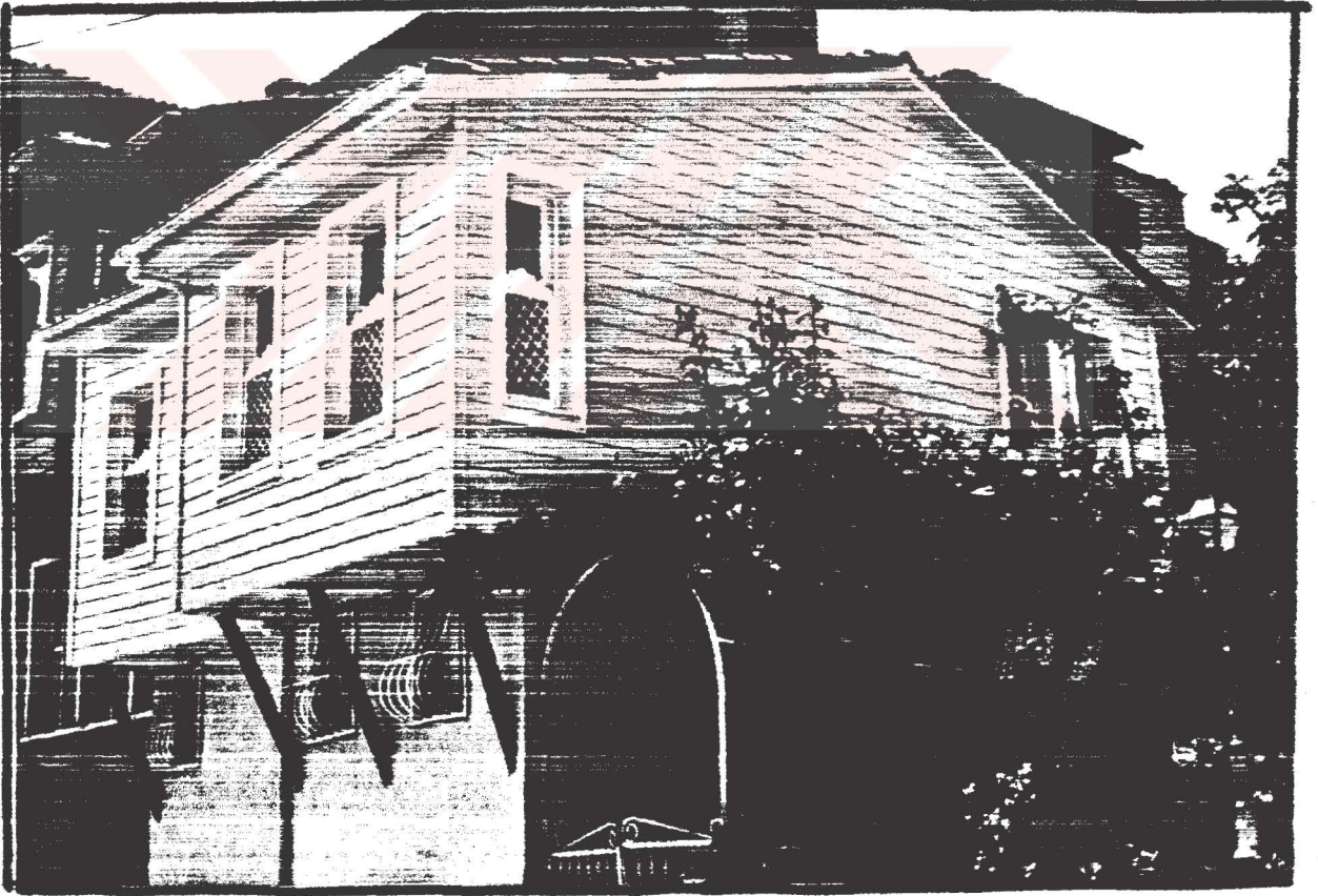
Kariye evleri Restorasyon Sonrası Görünüş
