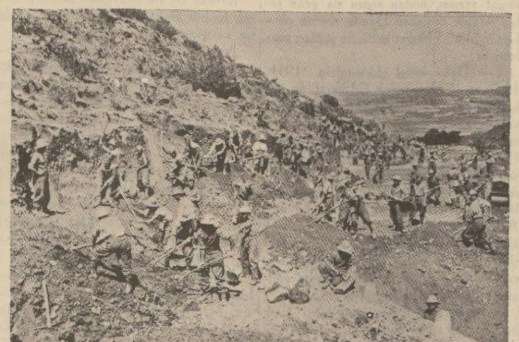
İtalyanların zaptettikleri yerlerde yol inşaatından bir görünüş
