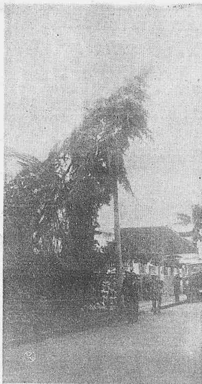
O vento que antecedeu o curto temporal de ontem, andou fazendo estragos no centro e bairros da cidade. Na esquina da Rua XV de Novembro, com a Sete de Abril, um pinheiro precipitou-se sobre os fios de alta-tensão, o que motivou receio entre os moradores das redondezas. O Corpo de Bombeiros foi mobilizado e lá estava, removendo o árvore arrancada.
