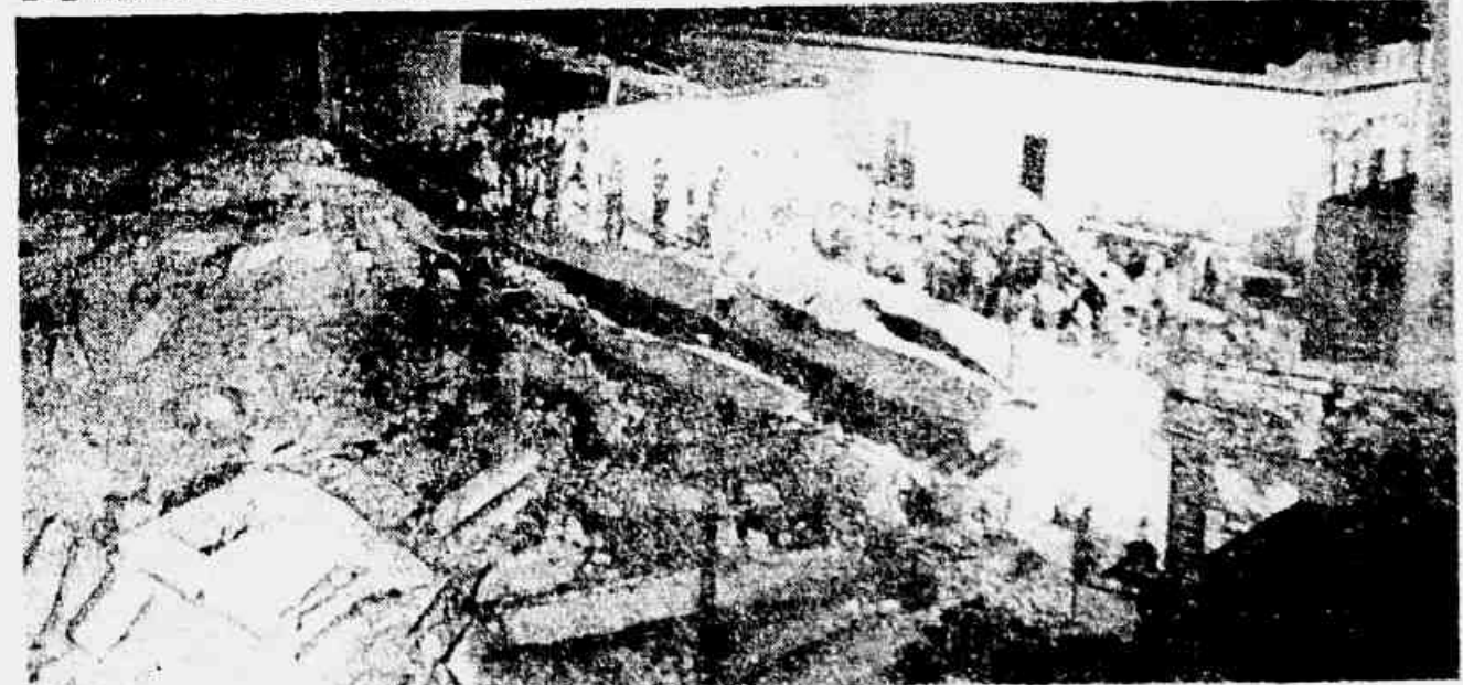
TODA a população de Piracicaba tem hoje o coração contínuo batimentado pela tragédia que foi o desabamento do Edifício Camargo, de que resultaram 25 mortos. De sob os escombros, já foram retirados mais três cadáveres enquanto 8 feridos permanecem internados na Santa Casa. Um helicóptero foi mobilizado para tentar amarrar cabos de aço nos locais ainda instáveis de prédio destruído. Leia na terceira página.
