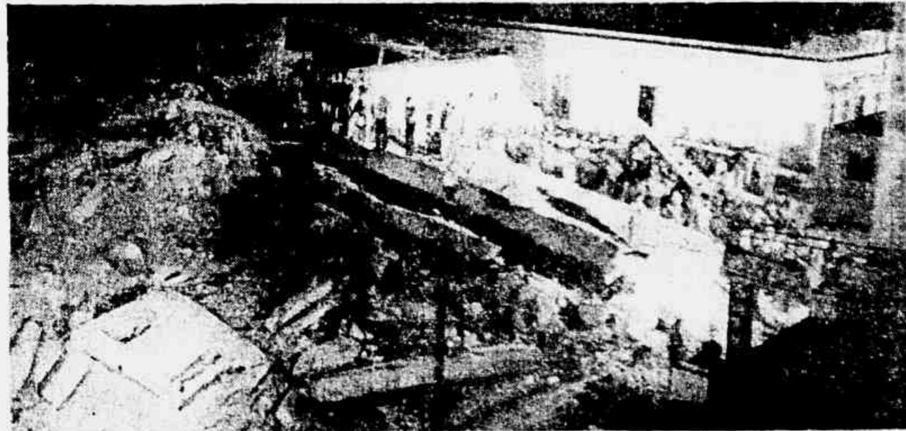
TODA a população de Piracicaba sem luta oficial, continua traumatizada pela tragédia que foi o desabamento do Edifício Comarbo, de que resultaram 23 mortos. De sob os escombros, foram retirados mais três cadáveres, enquanto 8 feridos permanecem internados na Santa Casa. Um helicóptero foi mobilizado para tentar amarrar cabos de aço às lajes ainda presas de prédios semidestruídos. (Leia na terceira página)
