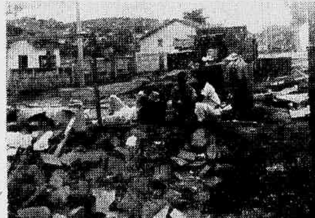
QUADRO DEPLORADOR — Nesta área, humildes operários, com sacrifício, construíram suas casinhas. Hoje resta apenas ruínas...
