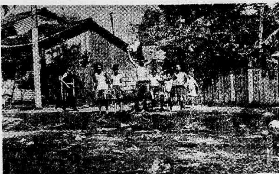
EXTENSO RIO DE LAMA — Em consequência de inexplicável descaso, a rua do Amparo está transformada em extenso rio de lama, foco de mosquitos e porta aberta para o recrudescimento da epidemia de tifo que ataca a cidade
