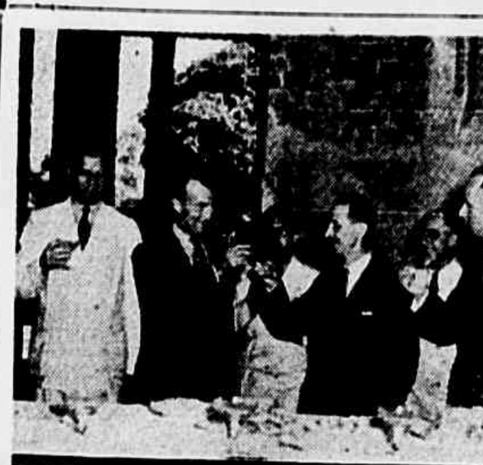
A FESTA DA CUMEIRA DO NOVO PALACETE DA EMBAIXADA NORTE-AMERICANA — A tarde de ontem, no luxuoso edifício em construção, destinado à Embaixada norte-americana e situado no centro de um grande parque da rua S. Clemente n. 230, teve lugar a festa da cumeira. Acompanhado do sr. John P. Simmons, conselheiro e Donald Rhiningsdal, embaixador Caffery percorreu demoradamente todas as dependências do prédio. Por último, no salão principal, onde fora colocada uma mesa de doces, o engenheiro chefe da firma construtora do edifício levantou a sua taça brindando o embaixador Caffery e demais pessoas presentes. No clichê temos um flagrante obtido durante a visita.
