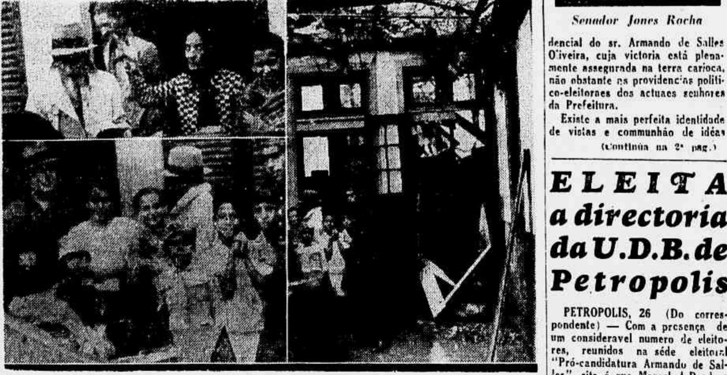
Diversos moradores da avenida da rua Senhor de Mattosinhos, julando no DIARIO DA NOITE, vendo-se também uma das casas daquella avenida, onde o fogo causou estragos
