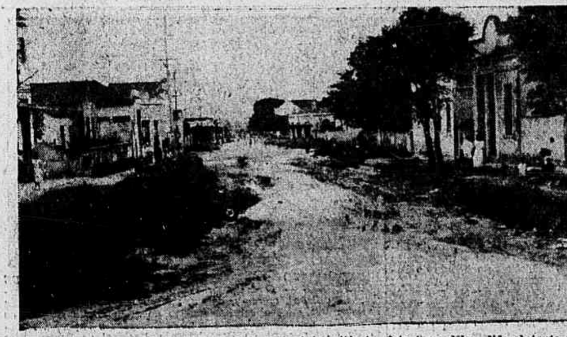
Há trechos na rua Montevideu absolutamente intransitáveis. Este é um deles. Não obstante ser essa rua muito importante para o populoso subúrbio da Penha, é deplorável o seu estado.
