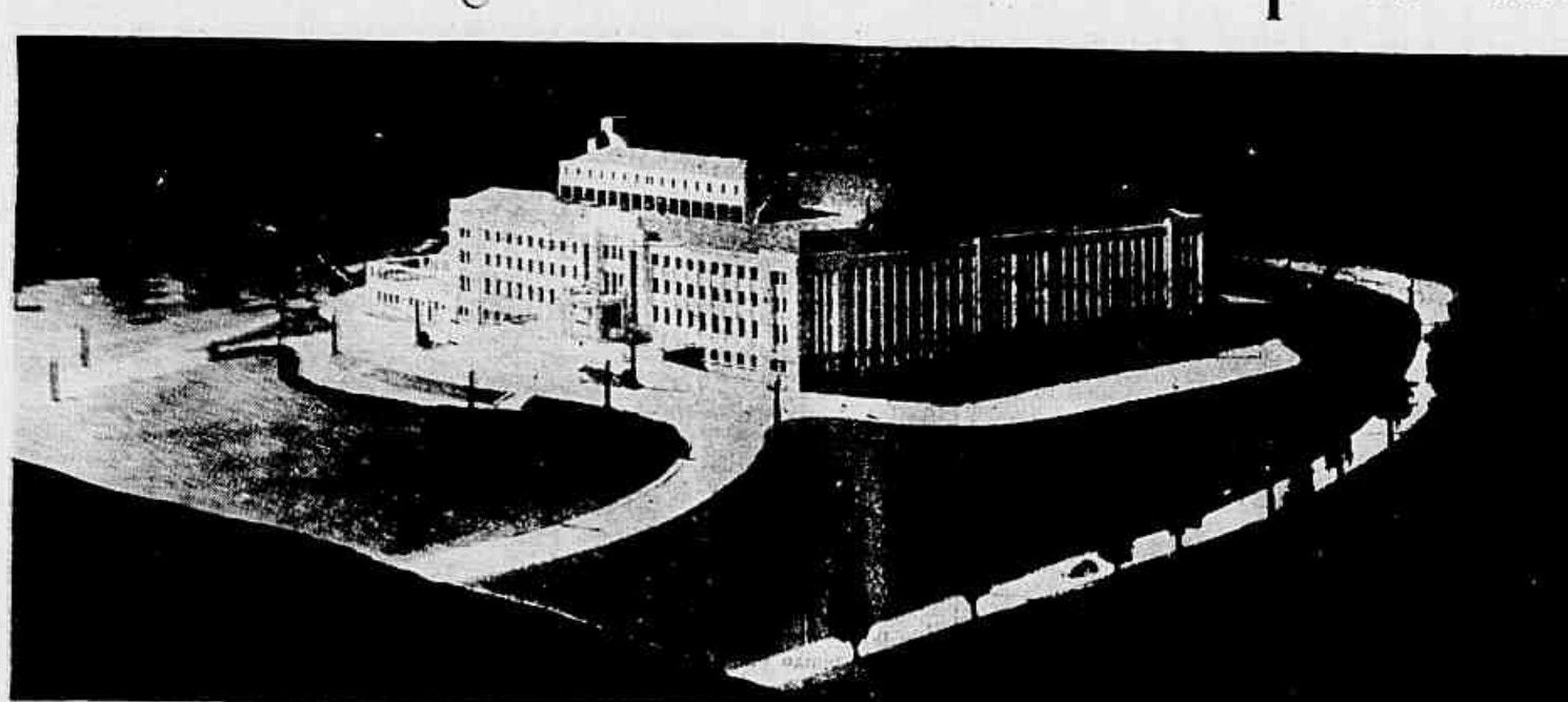
Vista geral do Grande Hotel
