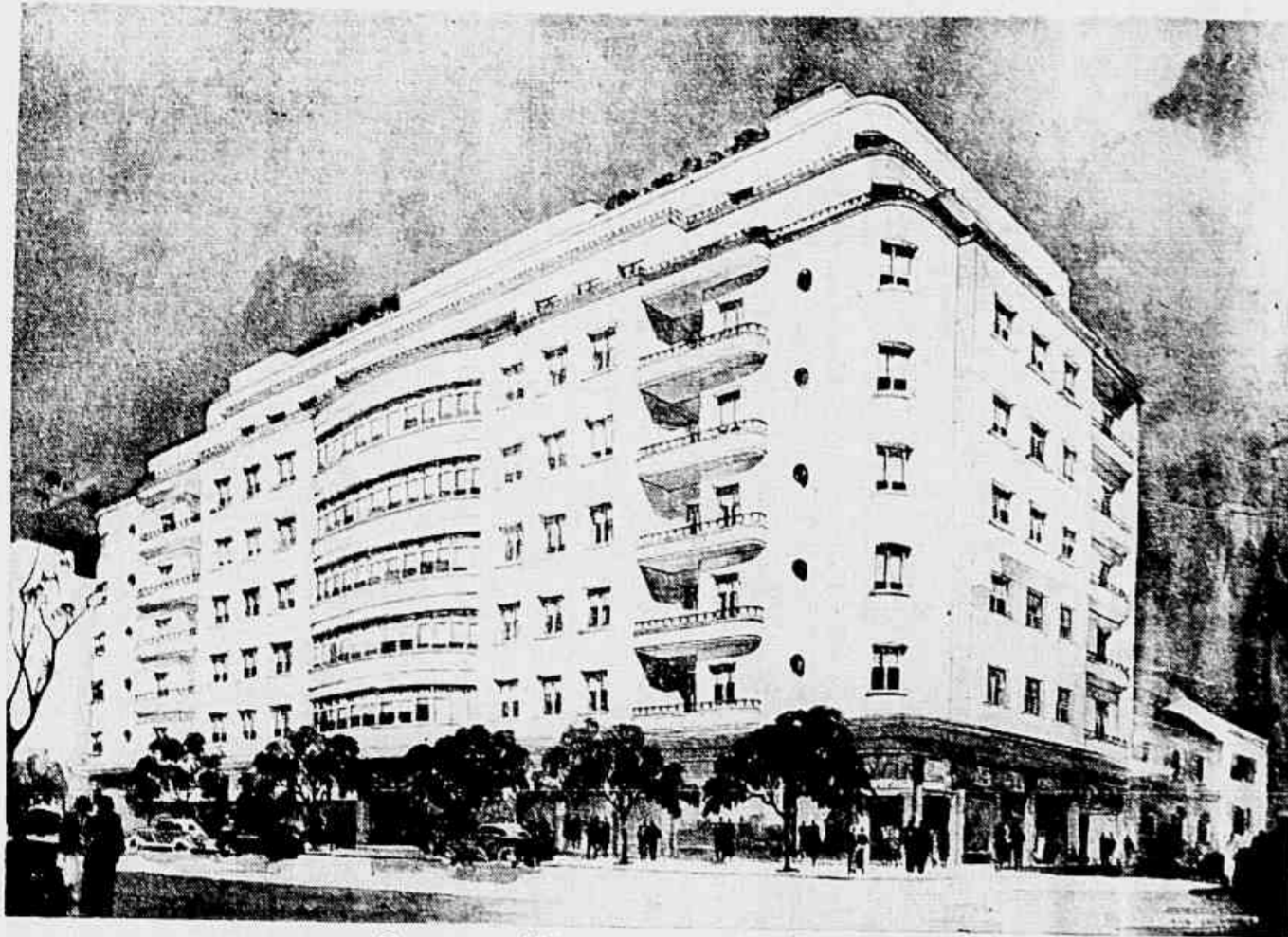
Construção já iniciada e em plena execução
