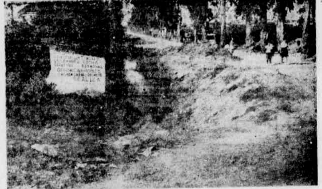
Aqui está a galeria feita pela emergência de uma necessidade premente de dar vazão aos detritos que vinham-se acumulando pela deficiência das manilhas. É preciso, entretanto, que o ministro Juarez Távora determine providências urgentes para solucionar em definitivo o problema sanitário da Vila São José
