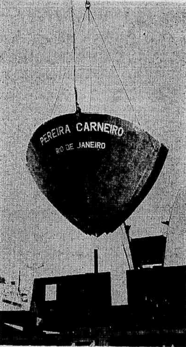
O navio Pereira Carneiro, cuja popa é vista na foto, quando era transportada para montagem nos estaleiros da Verolme, deverá ser lançado no mar até princípios de setembro, numa homenagem da Comissão de Marinha Mercante à memória do Conde Pereira Carneiro que, à sua atividade de homem de imprensa, como Diretor do JORNAL DO BRASIL, aliava a de pioneiro da construção naval no País. O navio, que é o maior já construído no Brasil, tem 10.500 toneladas e será utilizado no transporte de passageiros e cargas. A construção foi iniciada em fins do ano passado e atualmente estão sendo aplicados os últimos retoques na parte superior da estrutura.
