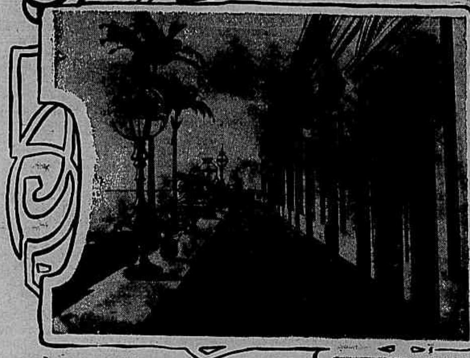
UM TRECHO DA FACHADA LATERAL DO PALACIO DO GOVERNO (S. LUIZ)
